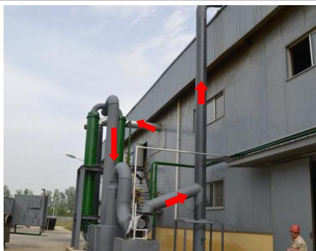
TMQ 冷凝废气处理系统
