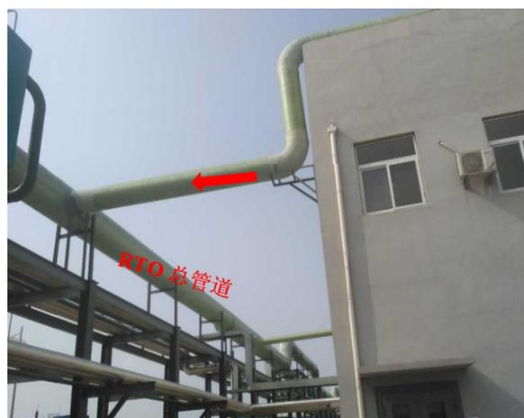
医药中间体装置发酵废气收集进 RTO 总管道
