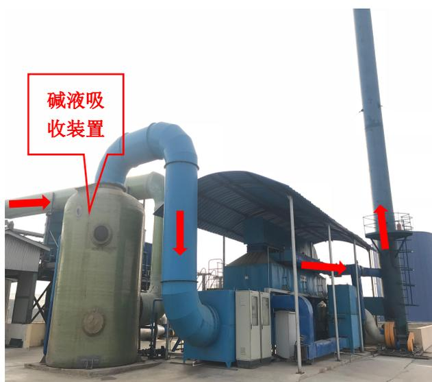
活性炭吸附+RTO 催化燃烧废气处理装置及排气筒
