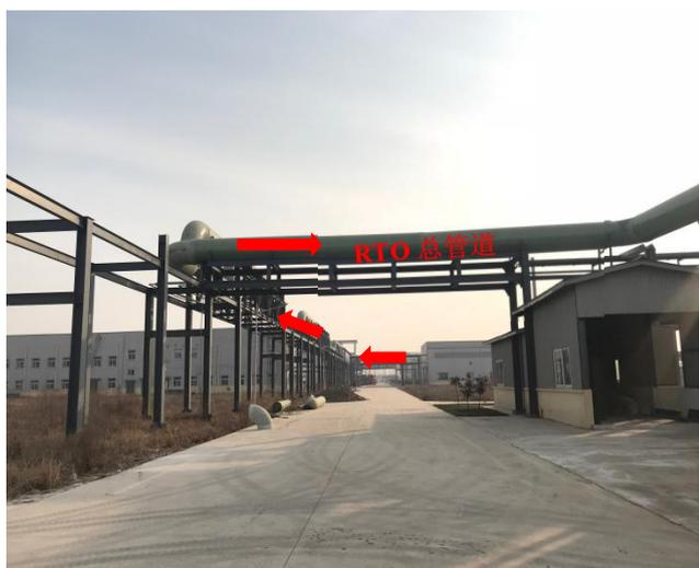
其他工艺生产通过管线收集进入 RTO 废气总管
